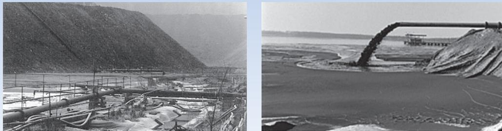
Zone d'entreposage des résidus d'Helmsdorf lors de l'exploitation : les résidus étaient déposés dans une vallée peu profonde adjacente à l'usine de traitement, contenue par deux barrages construits en stériles miniers. Aucun revêtement de fond pour la protection des eaux souterraines n'était installé avant l'exploitation et très peu de considération était accordée aux impacts potentiels dus à des fuites ou à une défaillance du barrage sur les communautés situées en aval de la retenue d'eau.
