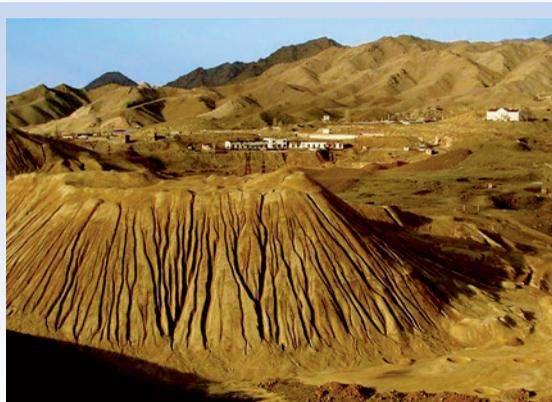
À Taboshar, une « colline jaune » de minerai broyé préparé pour une lixiviation en tas. Le manque de planification et de contrôle réglementaire combiné à des pratiques obsolètes d'extraction et de traitement ont conduit à des impacts environnementaux importants, y compris la diffusion d'agents de contamination provenant des déchets non confinés via le drainage des cours d'eau du site montagneux vers les plaines agricoles.
