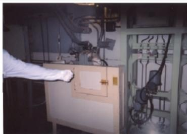
堆腔的防护进行了设计改造,在最大程度上降低反应堆厂房堆腔内的 $\gamma$ 通量和中子通量。设计改造的目的是将反应堆冷却剂排水槽(RCDT)和 INCORE 设备通道墙壁之间的空腔填满。因为应用 LBB(先漏后破)技术方案,不再需要堆腔,堆腔采用一块金属平板封闭(由金属片固定的混凝土填满腔体),在压力超过 2 psi(LOCA 基准工况)时打开。Almaraz 2 号核电厂 2001 年的第 13 次大修和 Almaraz 1 号核电厂 2002 年的第 15 次大修期间完成了这种设计变更。改进工作期间所受的内/外照射剂量可以忽略。功率运行时,反应堆冷却剂排水泵的维护通常会造成个人和集体照射剂量,完成设计变更后,个人和集体剂量明显降低。改进前和改进后的辐射水平如下表所示:
