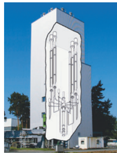
Primärkreislauf-Versuchsanlage PKL Facility. Areva, France
