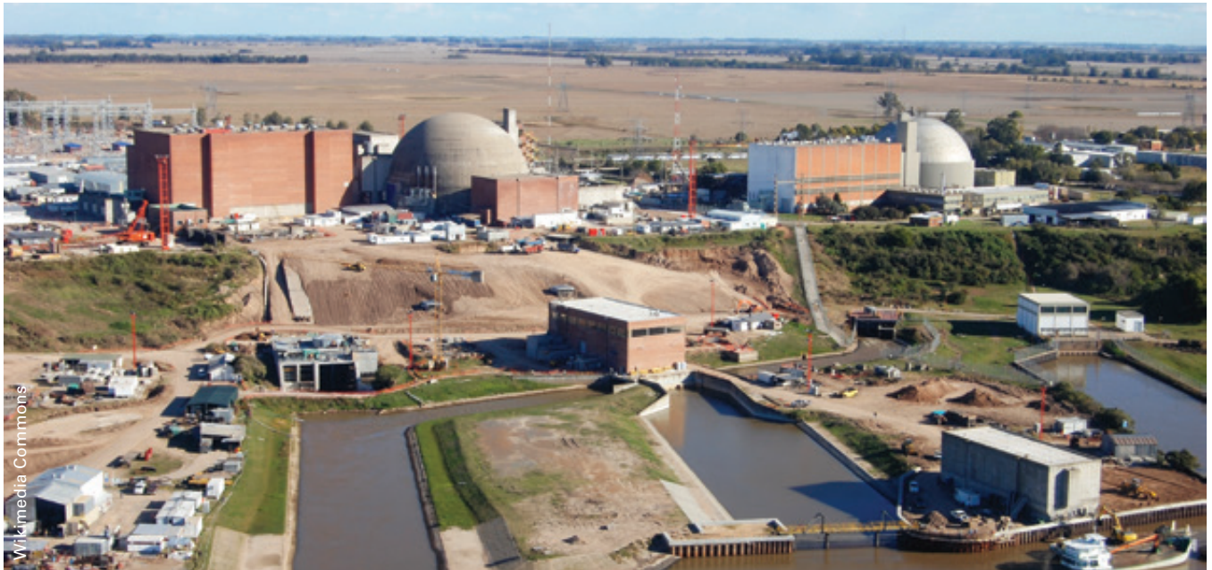
Atucha I - II Nuclear Power Plant, Argentina.
