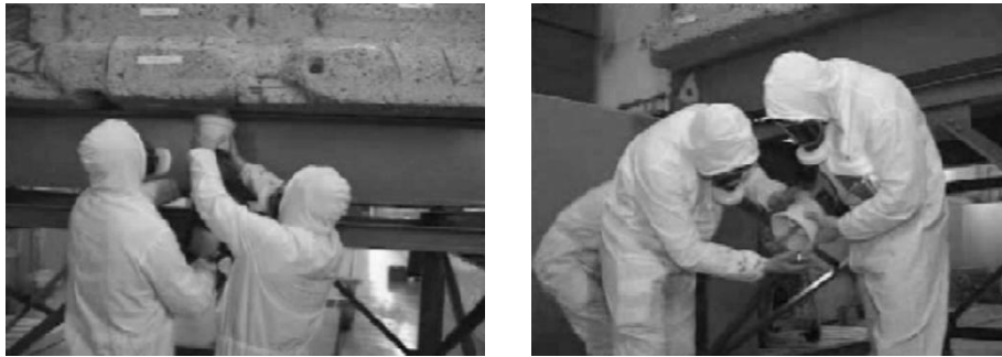
Figure 4.1 Prélèvement d'échantillons sur des surfaces de béton à l'aide d'une perceuse mécanique banale équipée d'une tête de fraisage, et à l'aide d'un bécher pour recueillir la poudre (haut) ; transfert de la poudre dans un conteneur de mesure (bas) (photos tirées de [KWW, 2004])
